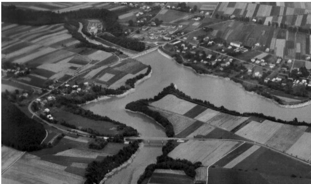
Fot. 4. Zbiornik Besko na rzece Wisłok. Okres eksploatacji ok. 30 lat. Główne zadania: zaopatrzenie w wodę; widoczna presja zlewni własnej zbiornika. (fot. W. Gorgolewski)
