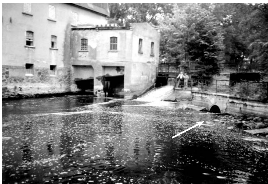
Ryc. 4. Przykład złego usytuowania przeplawki - rzeka Wel, Bratian.
