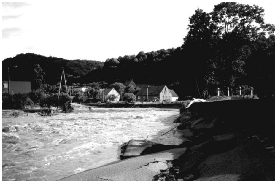
Fot. 3. Rzeka Bystrzyca – zniszczona droga w m. Bystrzyca Górna
