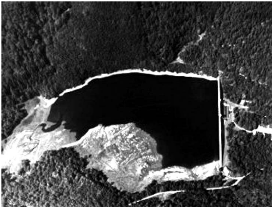
Fot. 5. Zbiornik Wapienica na rzece Wapienica. Okres eksploatacji ponad 70 lat. Główne zadanie: zaopatrzenie w wodę Bielska-Białej. Bardzo dobra jakość wody, minimalne procesy sedymentacyjne, brak presji zlewni. (fot. W. Gorgolewski)
