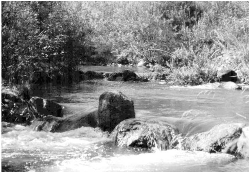
Ryc. 1. Przeplawka bliska naturze (obejście). Widoczna konstrukcja progu z głazów i powstających pomiędzy progami basenów, gdzie następuje wytracenie szybkości przepływu wody. Rzeka Lech, Niemcy. Fot. W. Wiśniewolski
