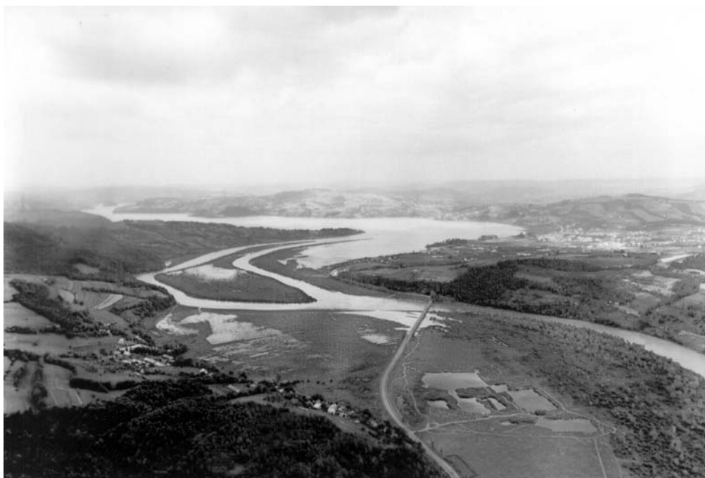
Fot. 3. Cofka zbiornika Rożnów na rzece Dunajec. Okres eksploatacji ponad 60 lat. Główne zadania: produkcja energii elektrycznej, ochrona przeciwpowodziowa i rekreacja. Bardzo intensywne procesy sedymentacyjne. (fot. Gorgolewski)
