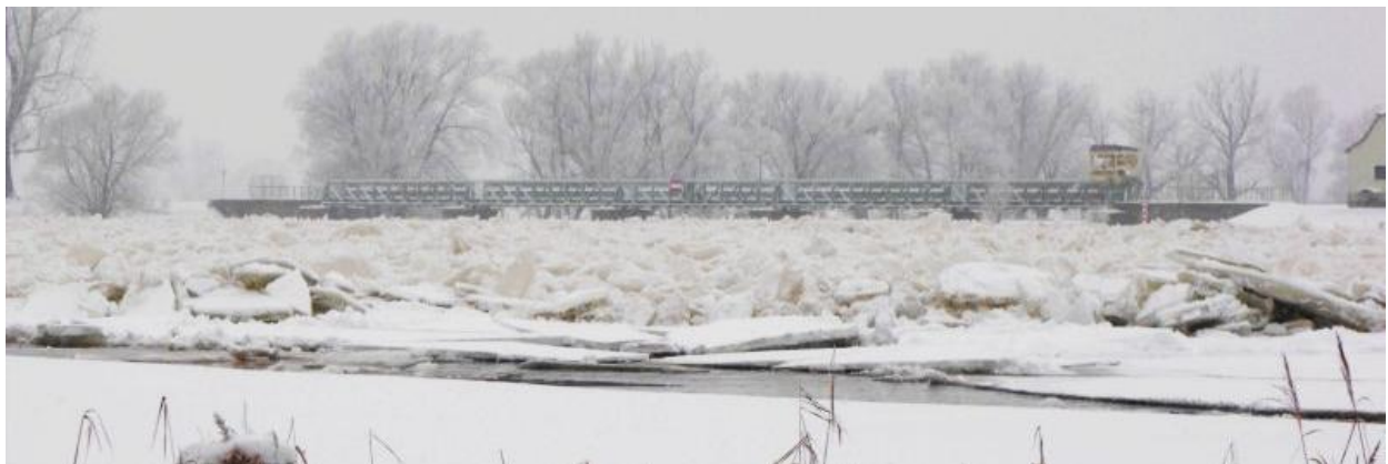
Abbildung 39: Eisversatz am Marienhofer Wehr am 23.12.2010 (Quelle: http://rzgw.szczecin.pl/ )
