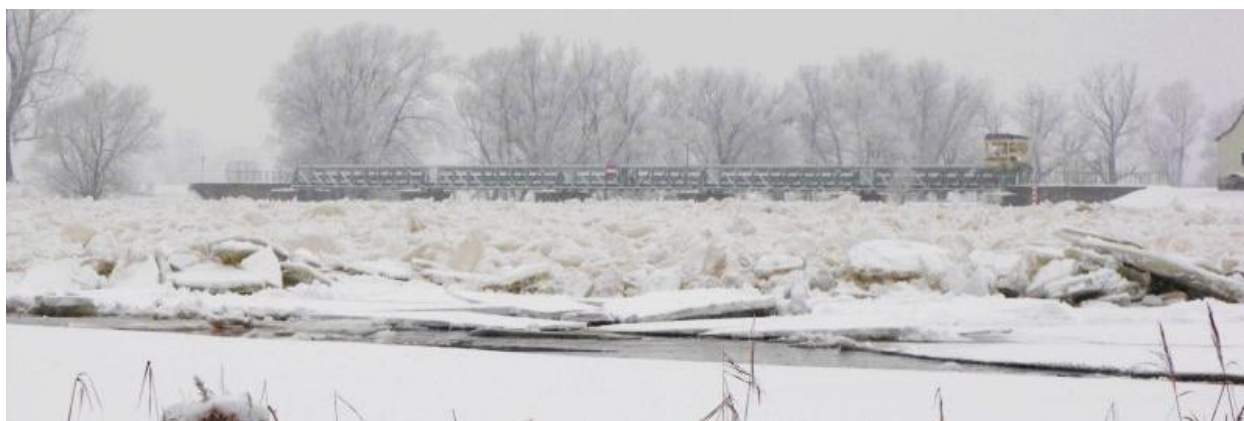
Ilustracja 39: Zator na jazu w Widuchowej (niem: Marienhofer Wehr) w dniu 23.12.2010 (źródło: http://rzgw.szczecin.pl/ )
