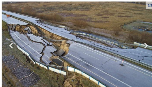
Autobahn 20: Wenn eine Straße im Boden versinkt
